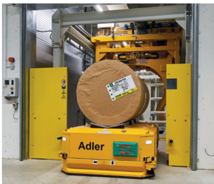
■ Abnahme von der Förderstrecke
