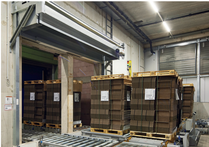
Einlagerung der Paletten durch Brandschutztor
